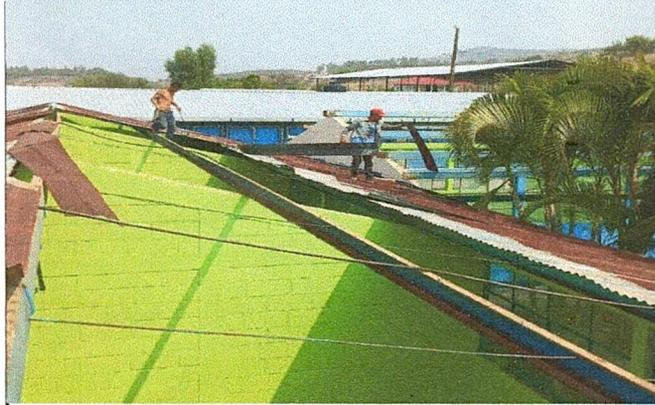
Foto 1: Mejoramiento de techo de lamina troquelada No. 26 y mantenimiento de estructura constante metalica.
